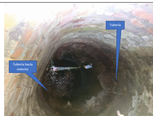
Foto No. 12. Vista al interior del aljibe aj-01-0096
