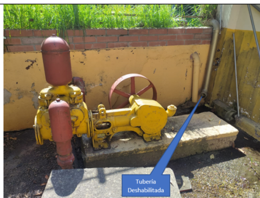
Foto No. 7. Tubería deshabilitada del aljibe aj-01-0095
