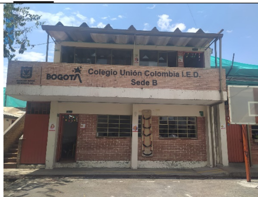
Foto No. 2. Vista del colegio al interior del predio
