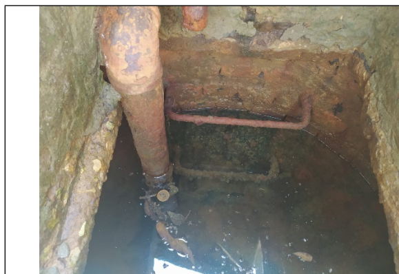
Foto No. 6. Vista al interior del del aljibe aj-01-0095
