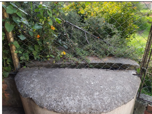
Foto No. 10. Vista general del aljibe aj-01-0096
