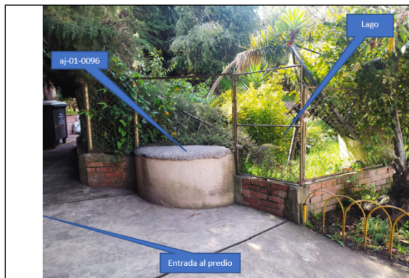
Foto No. 9. Ubicación del aljibe aj-01-0096
